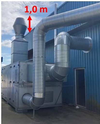
Afkast 1. Svejserspøg, slibestøv og olietåger
